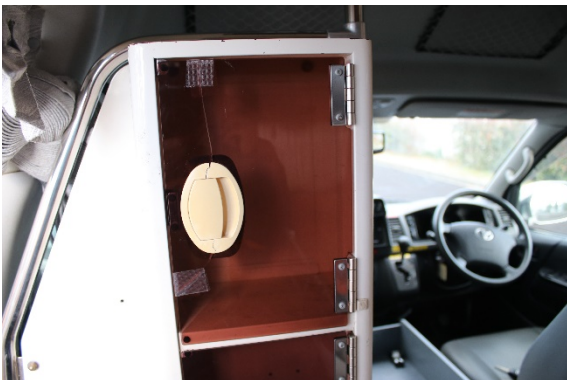
車内 扉割れあり
