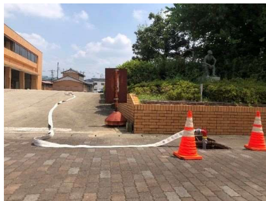
長久手消防署 給水状況
